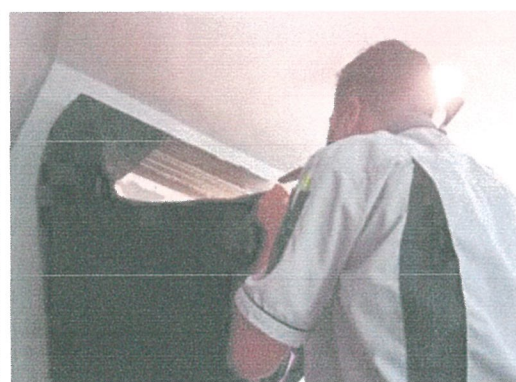
รูปภาพที่ 2.29 การล้างเครื่องปรับอากาศ
