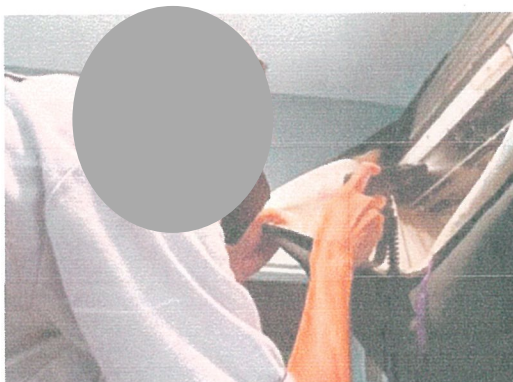
รูปภาพที่ 2.29 การล้างเครื่องปรับอากาศ
